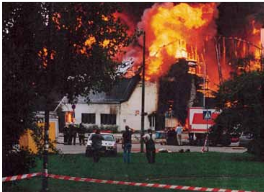
Totalskada under ombyggnad p g a svetsarbete.
